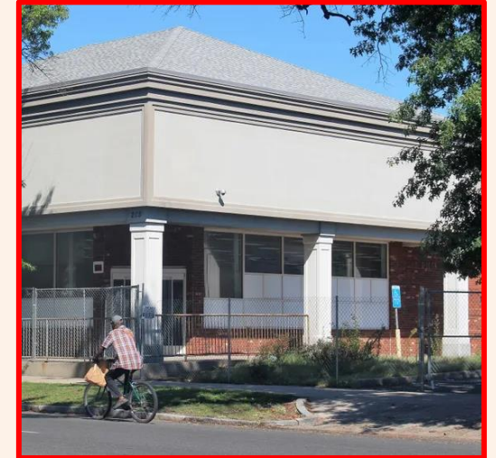
215 Whalley Av Rehab Clinic
