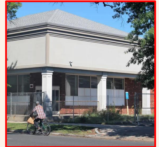
215 Whalley Av Rehab Clinic
